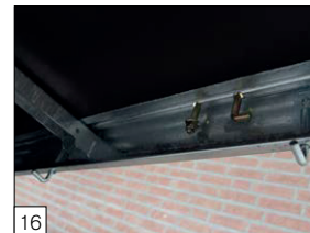
Option: schraubbare Anbindehaken an der Innenseite des Außenrahmens.
